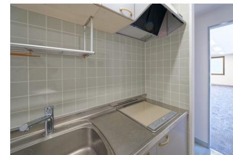
8F給湯室 (IHコンロ2口)
