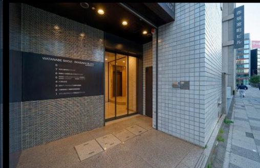
1F エントランス・エレベーターホールリニューアル済み
