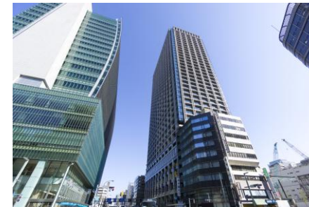
再開発が進む日本橋周辺
